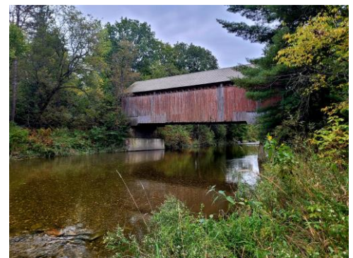
Pont de Milby, Milby
