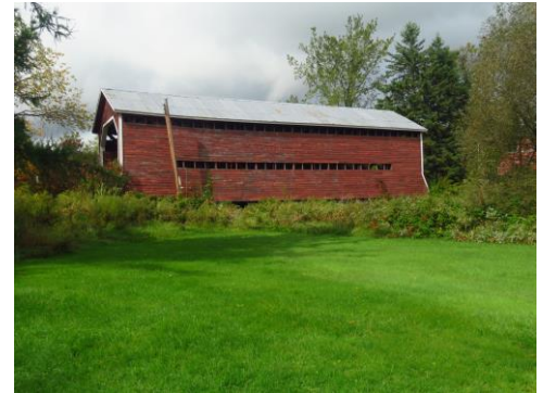
Pont Napoléon-Grondin, Saint-Éphrem-de-Beauce
